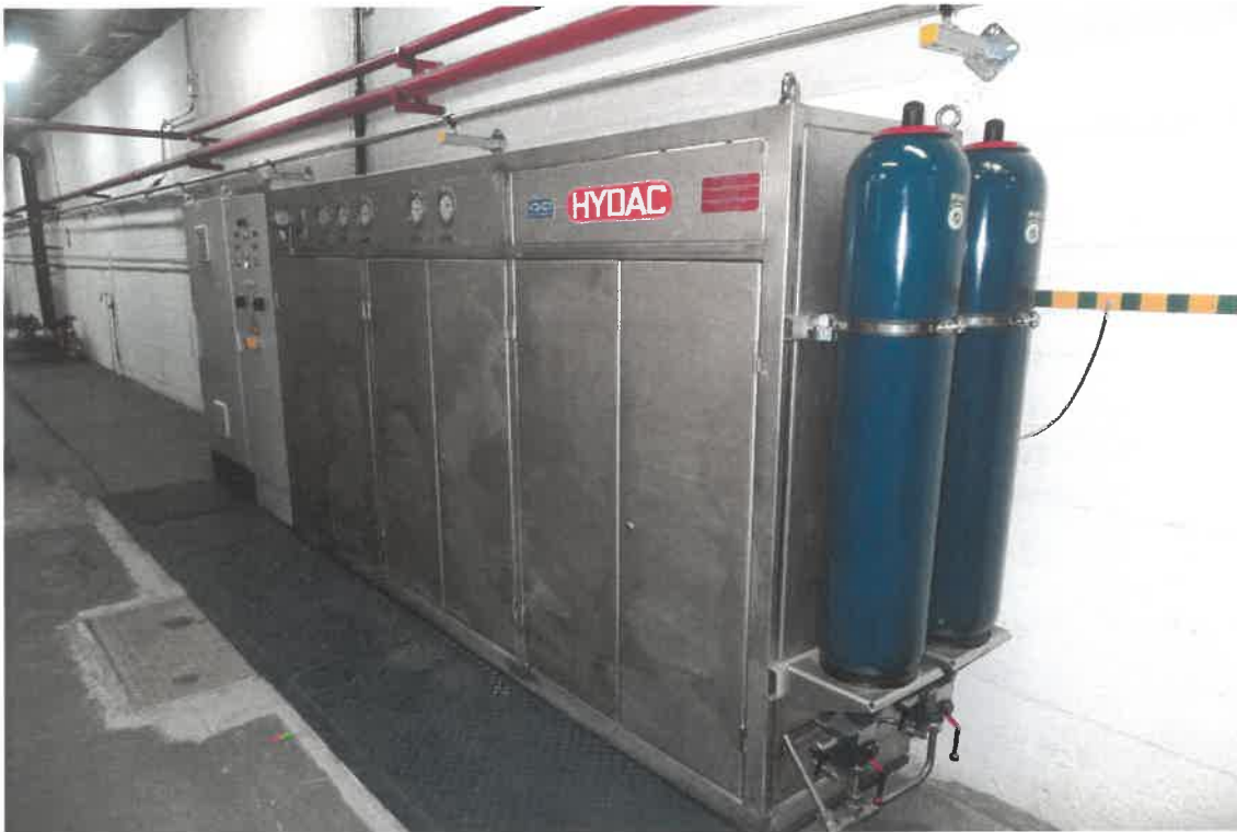
Zdjęcie 2 Hydrauliczny układ sterujący zaworu kulowego nr 2
