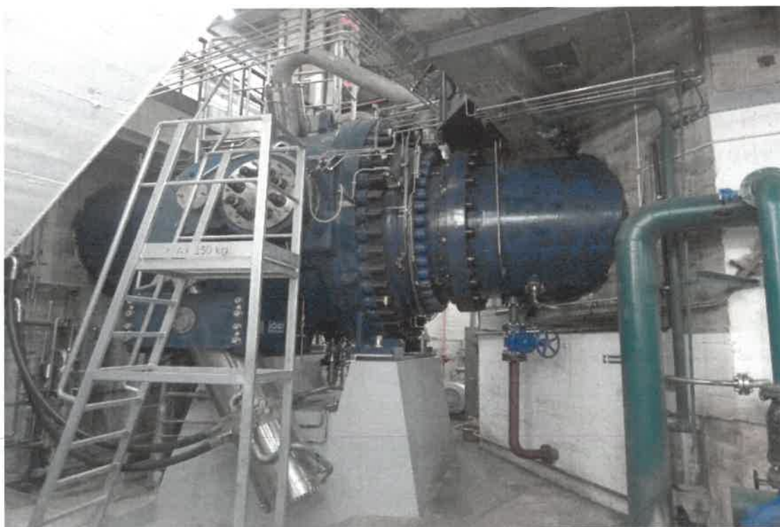
Zdjęcie 1 Zawór kulowy hydrozespołu HZ
